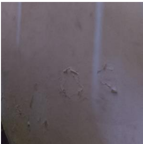
Pengecatan dan pelapisan ulang dinding eksisting karena sebagian terkelupas.
