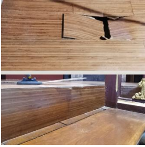
Pembongkaran lantai parket.
