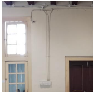
Pembongkaran seluruh utilitas eksisting.
