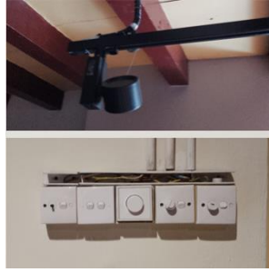
Pembongkaran seluruh utilitas eksisting.
