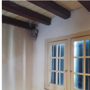
Perbaikan atap dan langit-langit yang bocor.
