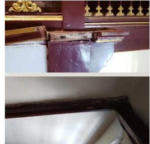
Perbaikan railing, dan tangga.
