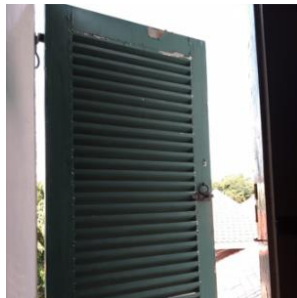
Pengecatan dan pelapisan ulang jendela eksisting karena sebagian terkelupas.
